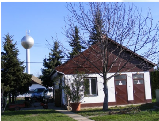
A kiszombori vízmű épülete
